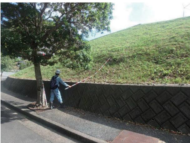
写真-2 小段が設置されていない盛土のり面
