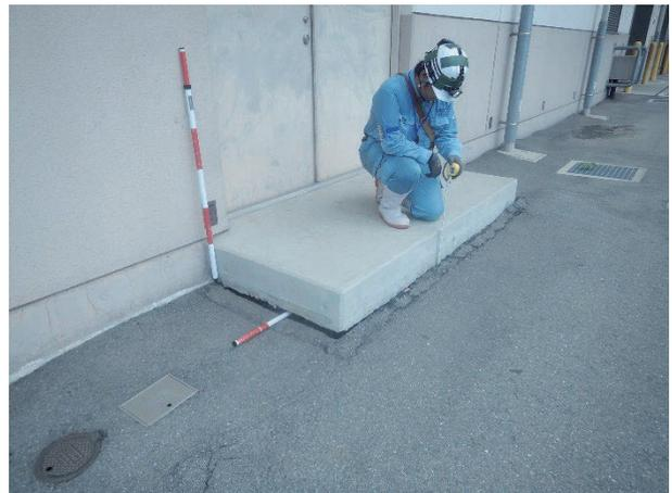
写真-3 宅地地盤の沈下
