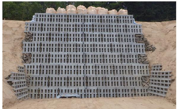
写真-1 ガンロック枠を用いた切土擁壁の試験施工(上載荷重載荷完了時: 2021年4月27日)
