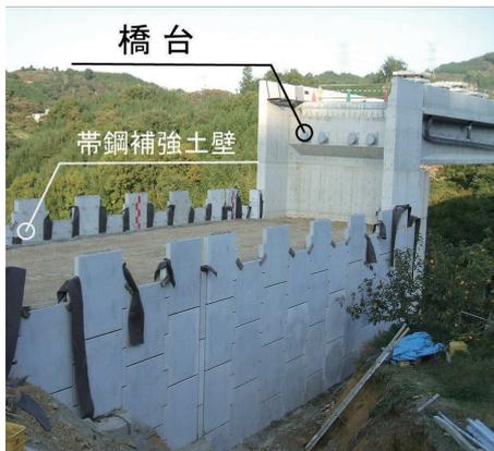
図-1 橋台背面アプローチ部への適用事例
