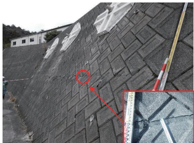
写真-4 ブロック積擁壁の水平亀裂
