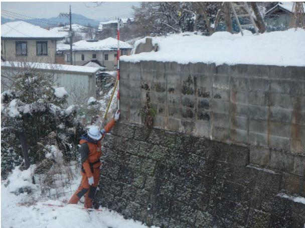
写真-1 標準的な構造に該当しない擁壁（増積み擁壁）
