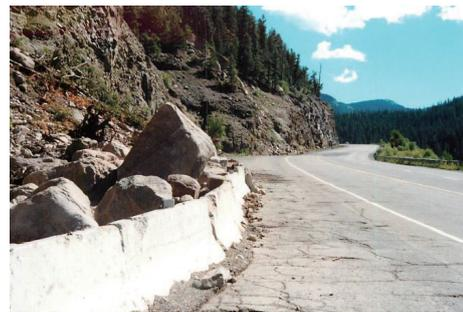
写真-2 コロラドの落石防護擁壁
