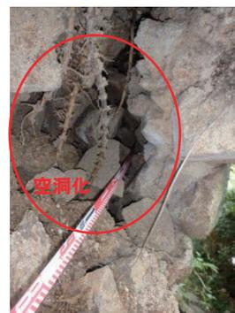
図-2 空石積擁壁背後の空洞化
