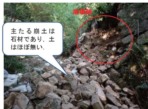
図-1 空石積擁壁の崩壊事例
