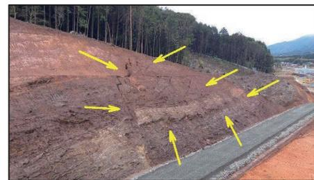
図-1 のり面のクラック発生状況
