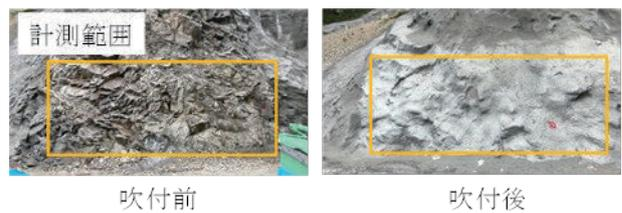
図-10 計測箇所の写真(吹付前と吹付後)
