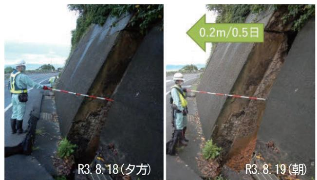
写真-2 構造物の移動状況
